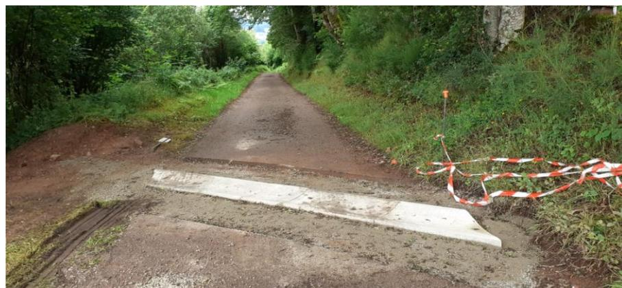
Pose de caniveaux CC2 double pente sur la route du camping pour l'écoulement de l'eau
